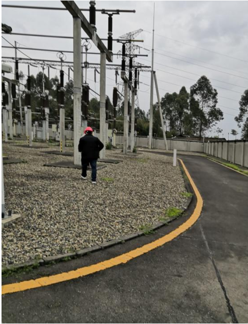
福盛变电站厂内道路现状
