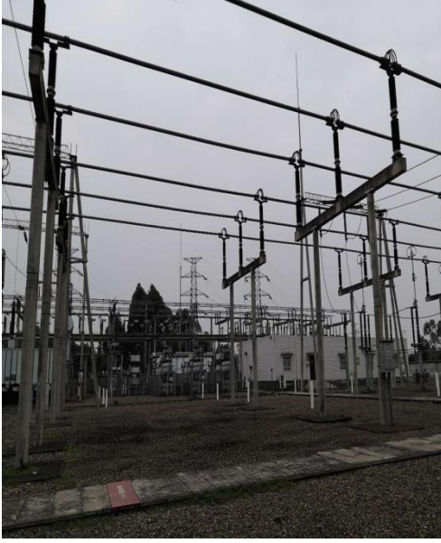
福盛变电站变电间现状
