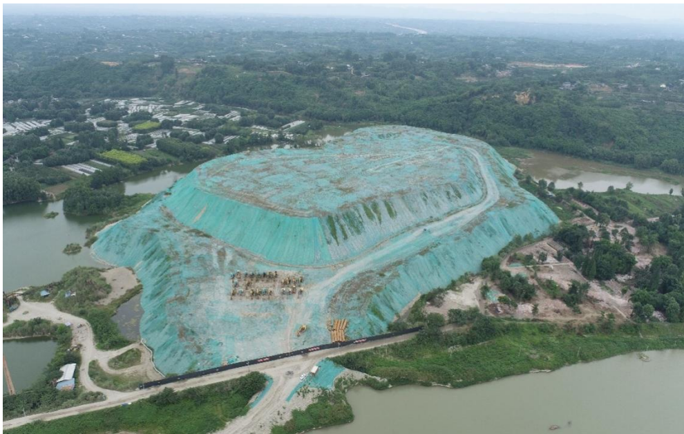
岷江干流汤坝航电枢纽工程暂存堆场现状
