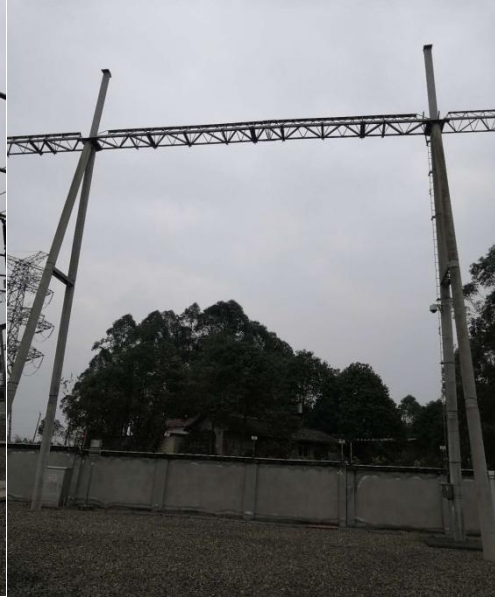
福盛变电站围墙现状
